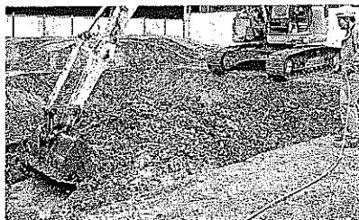
大洋は土壤汚染調査会社と提携し、その調査結果に基づいて浄化処理をする。盛り土したり、汚染土を取り除いた後に清浄土で埋め戻したりする。微生物に汚染物質を分解させるプランもある。
